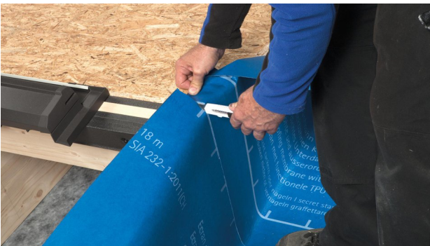
17. Seitlich am Aufkeilrahmen die Bahn aus der Fläche hochführen. Alternativ einen neuen Streifen SOLITEX WELDANO ablängen, am Aufkeilrahmen hochführen und unten auf der flächigen Bahn schweißen.
