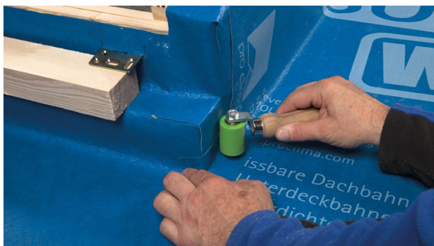
29. SOLITEX WELDANO Streifen anschweißen.
