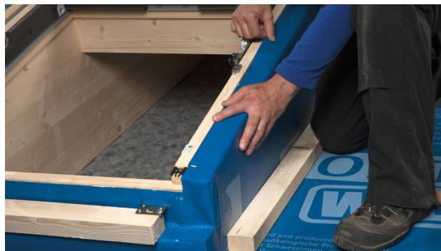
22. SOLITEX WELDANO entlang der Rahmenkante verkleben. Bahn mit Dehnschlaufe in das Kleberbett legen. Kleber dabei nicht ganz flach drücken, damit ggf. Bewegungen aufgenommen werden können.
