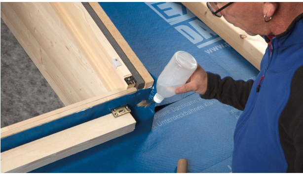
9. Zuvor gefaltete Ecke verschweißen.
