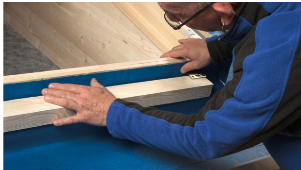
8. SOLITEX WELDANO-S mit Dehnschleife in das Kleberbett legen. Kleber dabei nicht ganz flach drücken, damit ggf. Bewegungen aufgenommen werden können.
