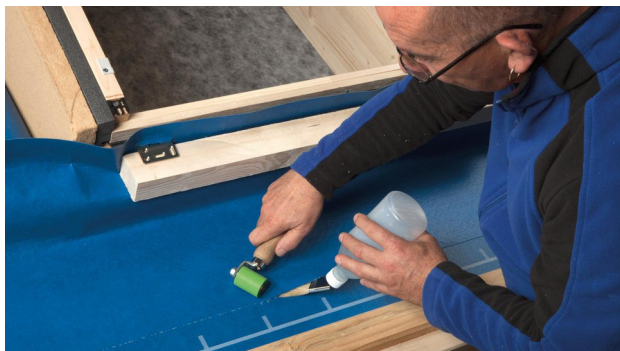
3. SOLITEX WELDANO-S an der Unterkante auf der flächigen SOLITEX WELDANO faltenfrei verschweißen (mit Quellschweißmittel oder Heißluftgerät).
