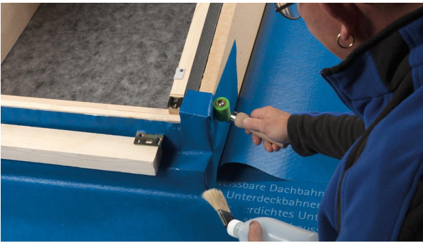
15. Überstände umfalten und mit der unteren Bahn verschweißen. Dabei besonders auf die Dichtheit der Ecken achten.
