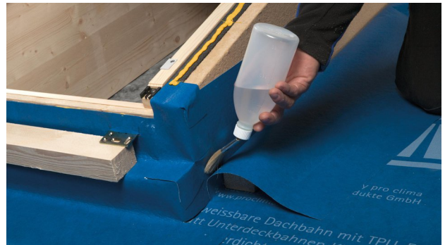
20. Unteren Eckbereich verschweißen.
