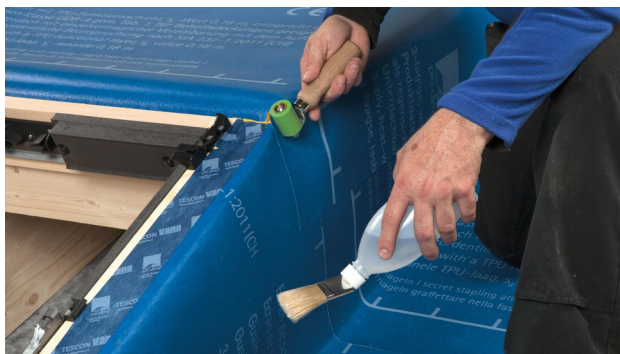
25. Seitlich die Lagen SOLITEX WELDANO miteinander verschweißen.
