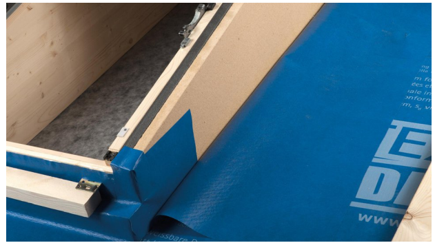
16. Fertige untere Eckabdichtung.
