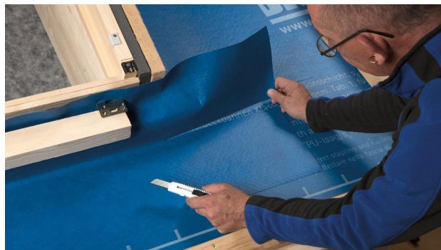
4. Horizontalschnitt bis Außenkante des Fensterrahmens/Dämmrahmens.
